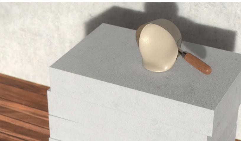
Leichtmörtel auf die Rückseite der Dämmplatte auftragen
