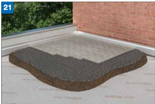
**(Bild 20)** Bei begehbaren Flächen, auf ebenen und festen Untergründen, wird die Splittschüttung direkt auf der verlegten Dränagebahn aufgebracht und anschließend der begehbarer Plattenbelag fertig gestellt.
