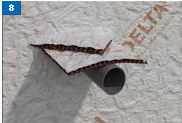
**(Bild 8)** Bei einer Kabel- oder Rohrdurchführung DELTA®-GEO DRAIN QUATTRO V-förmig einschneiden und ein ca. 30 x 30 cm großes Reststück in die Öffnung einschieben und die Durchführung abdecken. Bei der späteren Verfüllung dann zusätzlich Kies um das Detail anlegen, um das anfallende Wasser dort schneller abzuführen.
