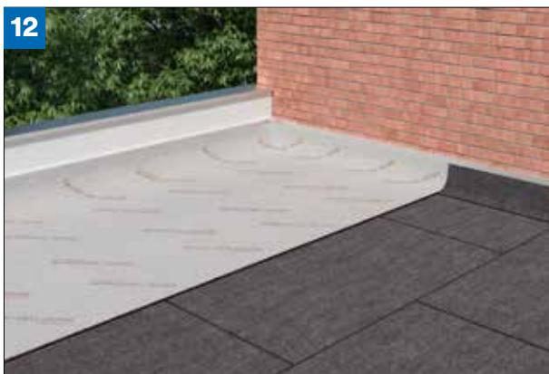
**(Bild 9)** Der abgedichtete Untergrund muss gründlich gereinigt werden, damit nach der Verlegung der Dränbahn keine Beschädigungen an der Abdichtung entstehen können. Im Fall einer Dachbegrünung muss diese Abdichtung wurzelfest sein oder durch eine zusätzliche Wurzelschutzfolie geschützt werden.
