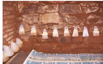
Bild zeigt die Trichtertränkung einer befallenen Wand
