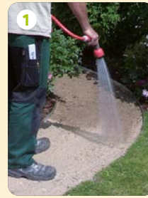
1 Schottertragschicht anfeuchten
