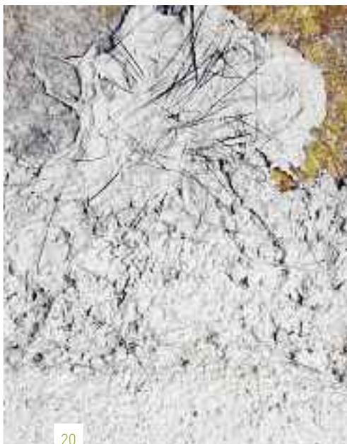
**Remarques importantes** Durant le durcissement, des fissures de retrait peuvent se former dans l'enduit de base minéral. Recommandation: application multicouche, garder humide. L'enduit frais ne doit pas être lissé à la taloche. L'enduit doit être suffisamment carbonaté jusqu'à l'application de la couche de peinture. Exception: HAGA Kalkfarbe (peinture à la chaux HAGA) peut être utilisé en technique «al fresco» (frais sur frais)
