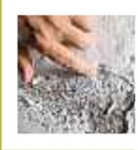
**Trattamento dell'HAGA Sanierporenputz SPS (intonaco a pori per ristrutturazioni SPS HAGA)** Mescolare accuratamente con una mescolatrice per ottenere una quantità ottimale di pori d'aria. L'intonaco può essere applicato manualmente o meccanicamente con una intonacatrice. Altrettanto adatte sono le intonacatrici variabili in modo continuo. L'impiego di altre intonacatrici deve essere concordato preventivamente. Spessore min. 2 cm, max. 3 cm ad ogni applicazione.
