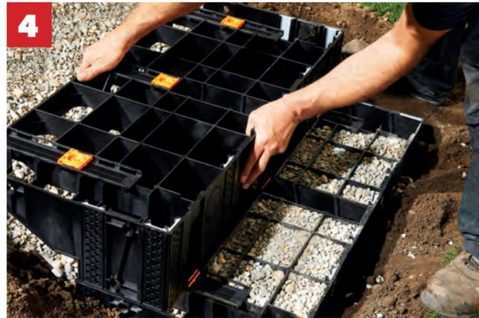
Die weiteren Stufen in die Schienen schieben ...
