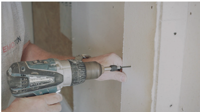
Montage der EMOTON PANELLO Raumklimaplatte
