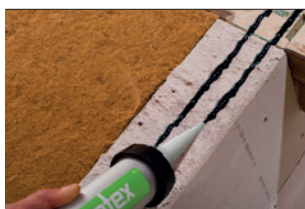
Abb. 9 Verkleben Anschlüsse und Bahnen
