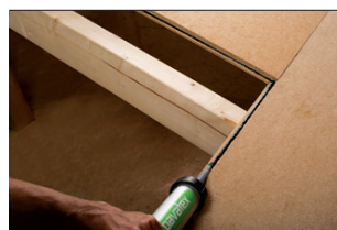
Abb. 10 Verkleben der Plattenstöße
