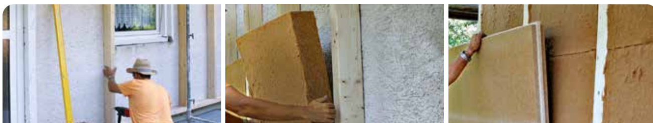
Abb. 2 Wandsanierung von außen: PAVAFLEX confort zwischen Holzständer, vollflächig über den Ständer der Klassiker ISOLAIR - die vielseitig einsetzbare, besonders robusten und druckstabile Dämmplatte (Dicken 40,60 und 80 mm)
