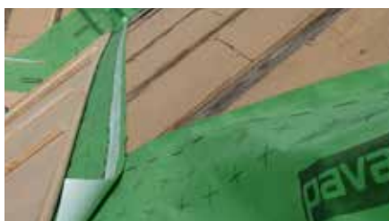
Abb. 2 Dachsanierung von außen ohne Beeinträchtigung des Innenraums.
