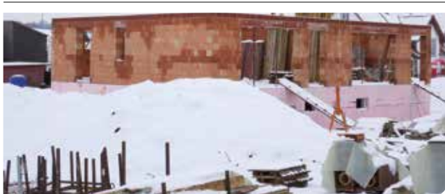
Abb. 1 Winterbaustelle mit starkem Feuchteintritt im Ziegelmauerwerk
