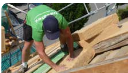
Abb. 2 Dachsanierung von außen ohne Beeinträchtigung des Innenraums.
