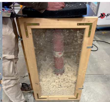
Verdichtetes Einblasen mit Schlauch
