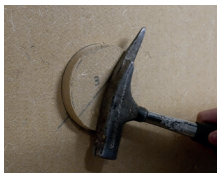
1.5 Entnommenen Bohrkern einsetzen Den Bohrkern umlaufend gleichmäßig mit PAVACOLL oder einem geeigneten Holzleim bestreichen und anschließend passgenau einsetzen.
