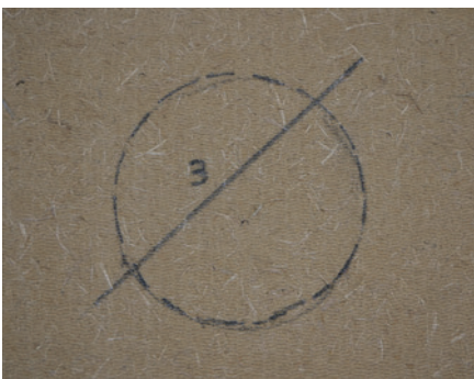
1.1 Einblasöffnung anzeichnen Position der Einblasöffnung festlegen, markieren und eindeutig nummerieren.
