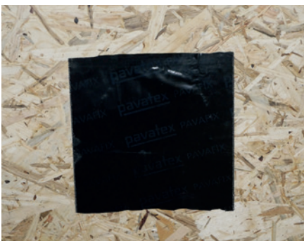
1.4 Einblasöffnung luftdicht verschließen Nach Abschluss der Einblasdämmung die Öffnung mit PAVAFIX 60/150 verschließen
