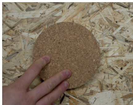
1.5 Verschluss bei Brandschutzanforderungen Bei erhöhten Brandschutzanforderungen ist die Einblasöffnung mit einem geeigneten Kork-Verschlussstopfen gemäß den Vorgaben der jeweiligen Landesbauordnung auszuführen.
