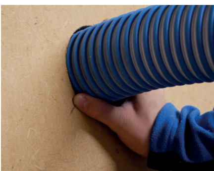
1.4 Einblasdämmung einbringen Einblas Schlauch mit Abdichtschwamm einsetzen und Dämmstoff gemäß Rohdichtentabelle gleichmäßig und setzungssicher einbringen.
