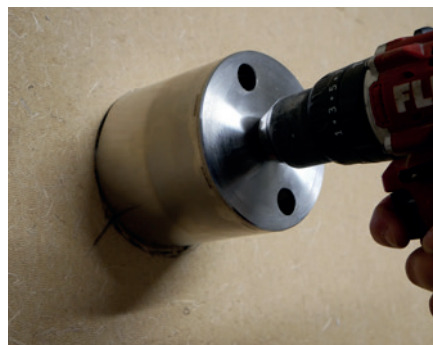
1.2 Einblasöffnung herstellen Die Einblasöffnung wird mit dem PAVATEX Weichfaserbohrer sauber und passgenau hergestellt. Mit gleichmäßigem Lauf und mäßigem Anpressdruck bohren. Kurz vor dem Durchbruch den Druck reduzieren, um saubere Schnittkanten zu erzielen.
