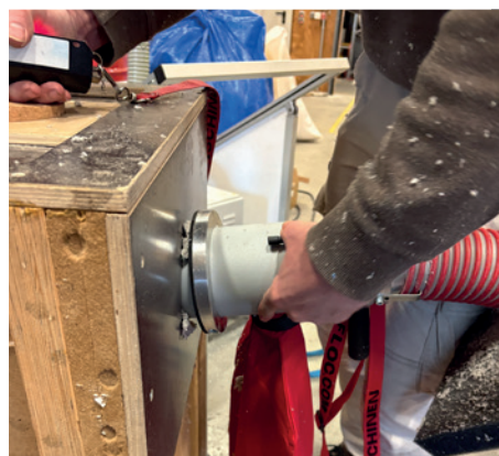
Verdichtetes Einblasen mit entlüftender Drehdüse
