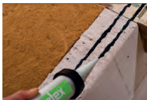
Abb. 18 Verkleben Anschlüsse und Bahnen
