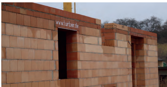
Abb.3 Winterbaustelle mit starkem Feuchteintritt im Ziegelmauerwerk
