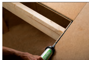
Abb. 19 Verkleben der Plattenstöße
