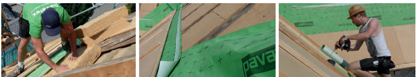
Abb. 17 Dachsanierung von außen ohne Beeinträchtigung des Innenraums.
